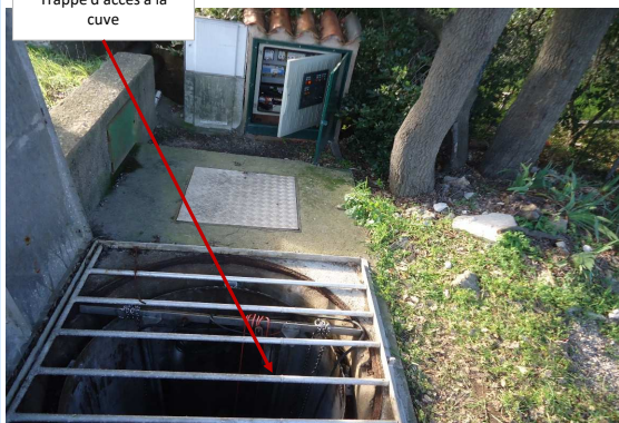
Trappe d'accès à la cuve
