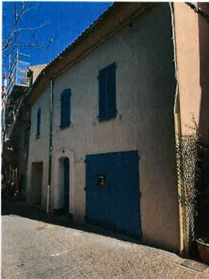
Façade côté rue :
