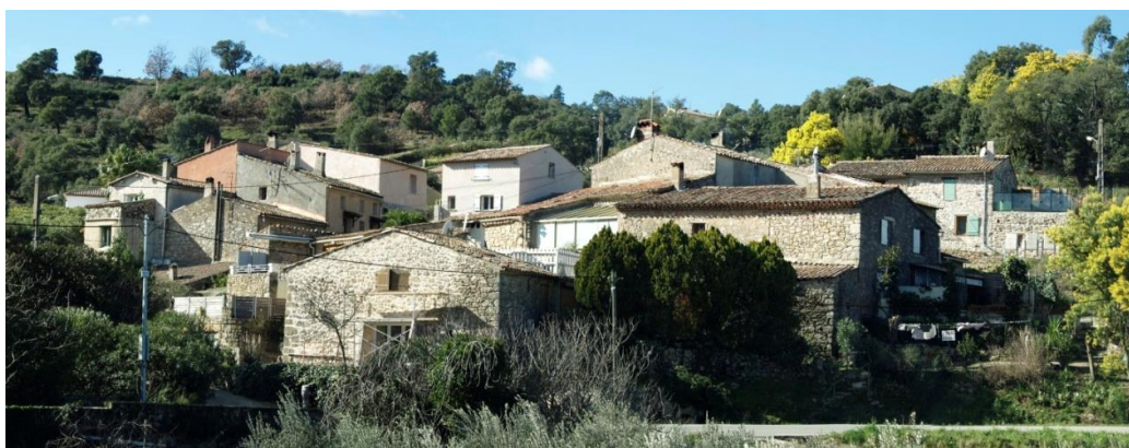
Le bâti ancien des Pierrons
