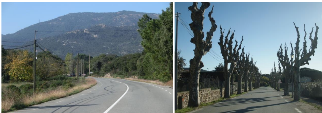
La D74 depuis Sainte-Maxime et alignement d'arbres en entrée de ville
