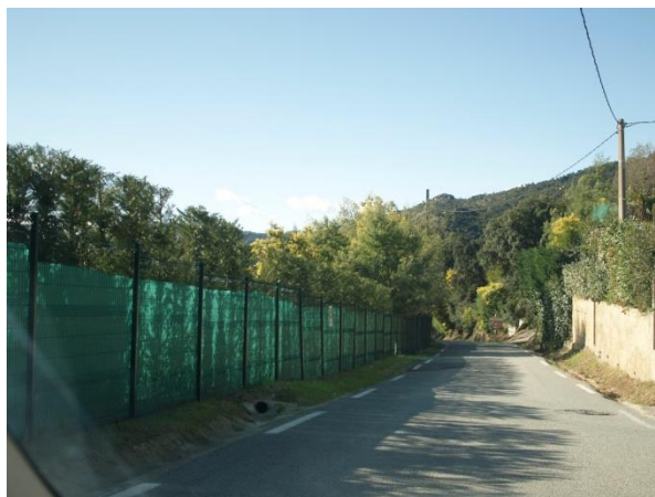
Exemple de clôture le long de la D44 impactant l'environnement paysager
