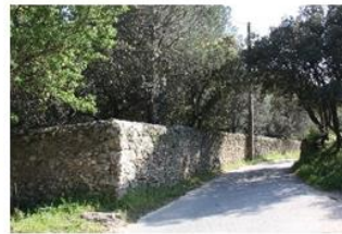
Mur en pierre chemin du Préconil
