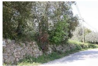
Mur en pierre des Brugassières
