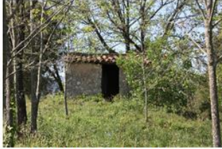
Cabanon des Brugassières
