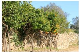
Mur en pierre du Vernet
