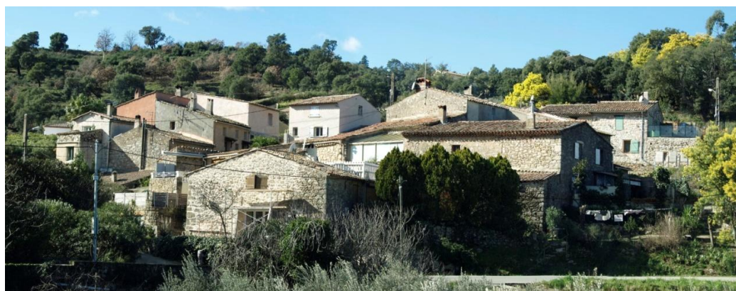
Le bâti ancien des Pierrons
