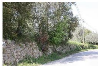
Mur en pierre des Brugassières
