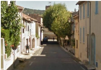
Vue rue Jean Jaurès avant travaux
